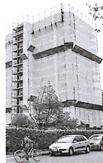
Un cantiere del Superbonus 110, dopo l'esplosione dei costi il governo è tornato agli incentivi classici del 50%
