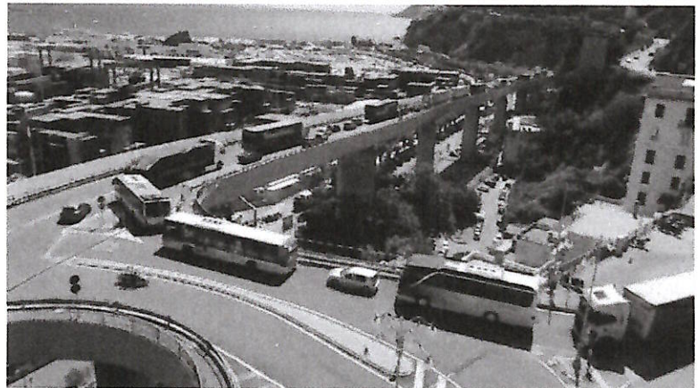
Traffico in tilt sul viadotto Gatto
