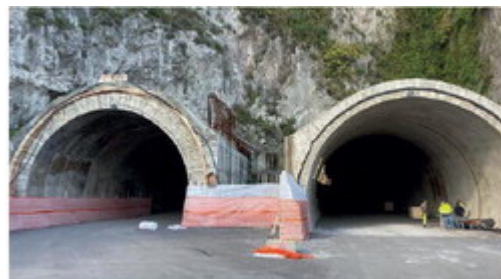
Il cantiere delle gallerie di Porta Ovest
