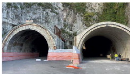
Il cantiere delle gallerie di Porta Ovest
