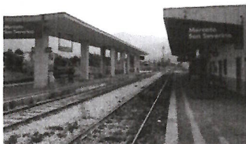
La stazione ferroviaria di Mercato San Severino
