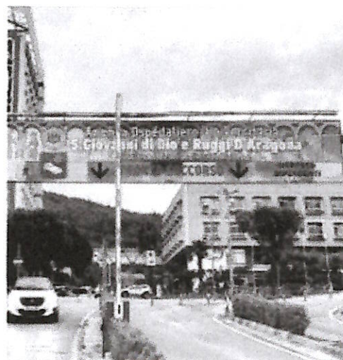
L'ingresso dell'ospedale “Ruggi d'Aragona”
