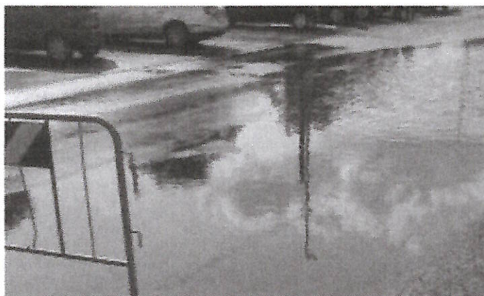
Via Nuova San Marzano invasa dall'acqua anche in piena estate
