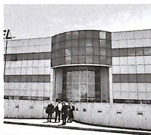
Aixtron ha acquisito un sito produttivo esistente a Orbassano con macchine già installate ma prima inutilizzate
