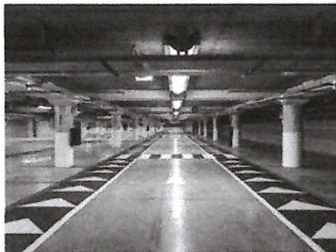
Il parcheggio sotterraneo di piazza della Libertà
