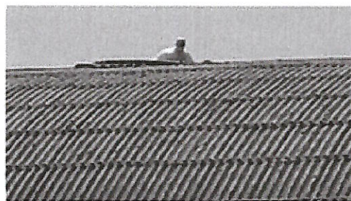
Un operaio al lavoro sui vecchi capannoni della ex D'Agostino
