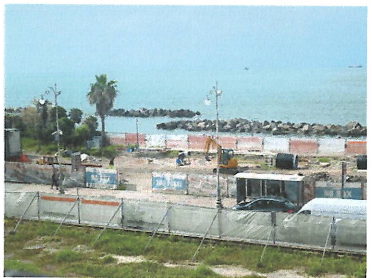
L'area del cantiere di piazza Cavour
