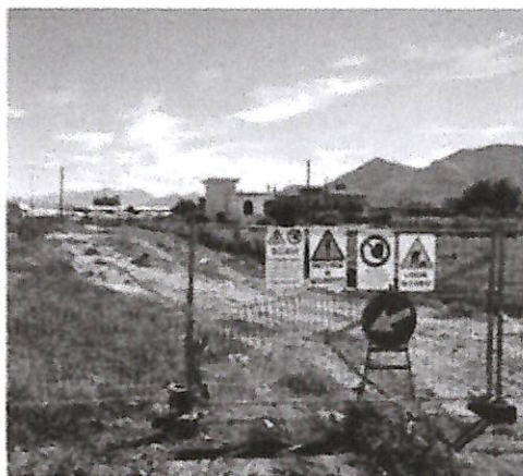
Uno dei cantieri attualmente presenti nell'area Pip di Scafati
