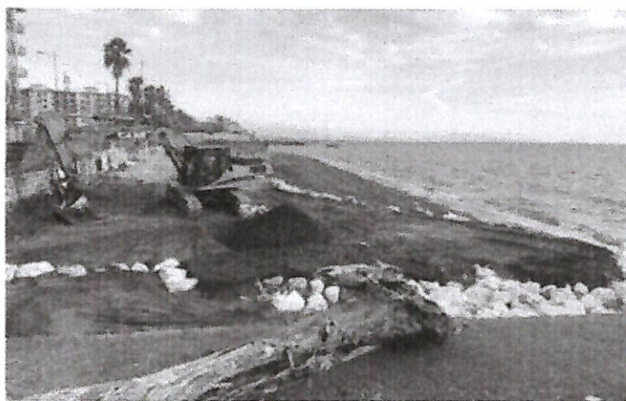
I lavori per il ripascimento della spiaggia nella zona di Torrione
