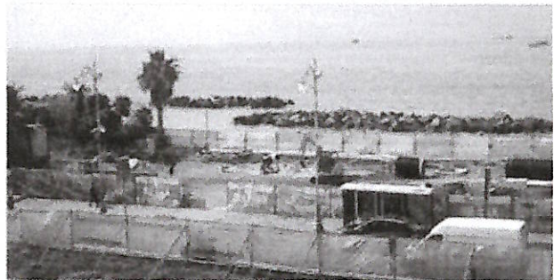
Il cantiere dei lavori in piazza Cavour
