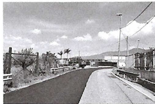
Una delle strade interessate dai lavori sul territorio comunale nocerino
