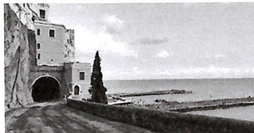
Il tratto della statale 163 ricostruito in tempi record
