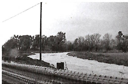
Il cantiere dell'ex Pip nautico, sul litorale
