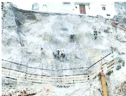
Sprint sui lavori di messa in sicurezza della frana di Amalfi
