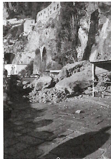
Alcune immagini della frana che ha interessato la statale
