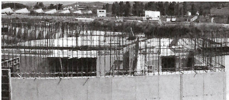
Punto di svolta per il Palazzetto dello Sport
