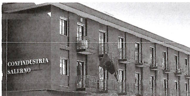
Sopra la sede di Confindustria Salerno. Al centro la zona industriale
