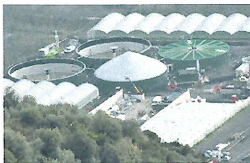
Gli impianti di biogas nella frazione sarnese di Foce
