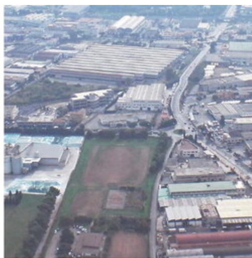
La zona industriale di Salerno
