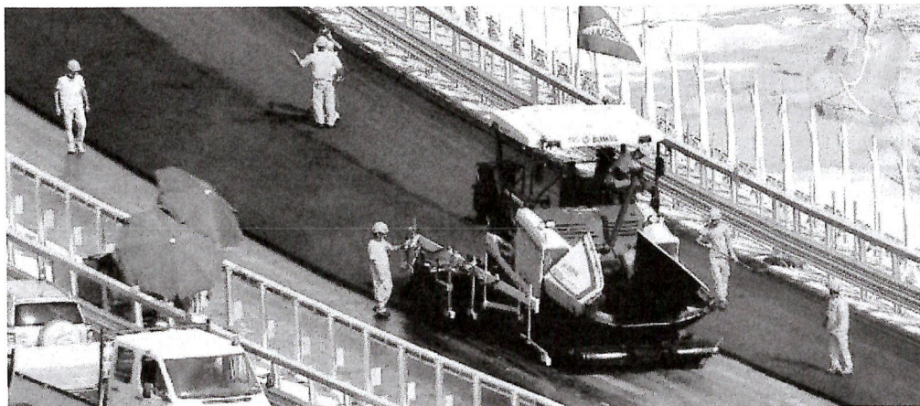
Un tratto del nuovo Ponte di Genova
