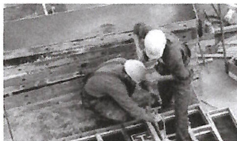
Operai edili impegnati in un cantiere
