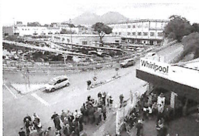
La sede principale dell'ex Whirlpool in via Argine: sarà ristrutturata. Ora sono in corso le demolizioni dei vecchi opifici
